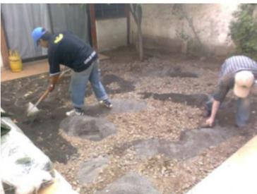
• Con el estabilizado sobre el terreno, se agrega la arena y se mezcla para lograr uniformidad.
