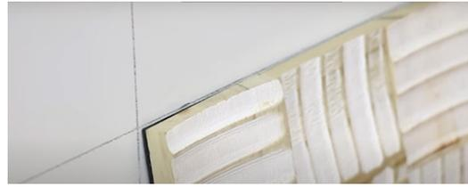
Aplicar una cantidad delgada de adhesivo con una pistola aplicadora. El elemento a pegar debe ser colocado de inmediato y luego presionado con firmeza. Las manchas de adhesivos pueden removerse con los limpiadores STAUF específicos según el grado de fraguado o dureza alcanzado. Antes de aplicar el limpiador sobre toda la superficie, probar en una zona que no quede a la vista o en una muestra si el producto afecta la superficie de la madera con tratamiento final de fábrica.
