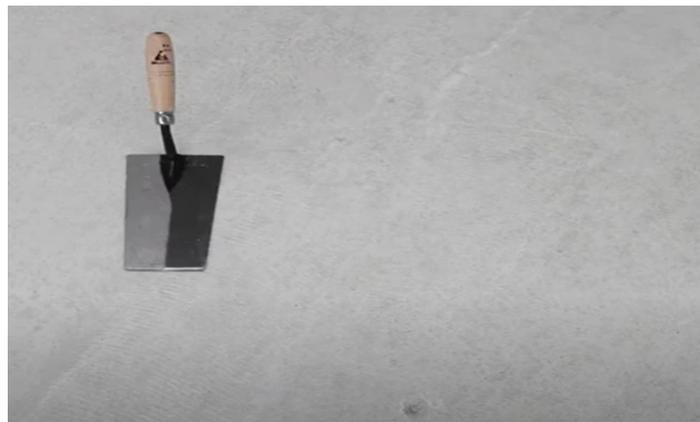
La superficie debe estar completamente limpia, libre de suciedad y grasa antes de comenzar la instalación. Para aplicación sobre hormigón nuevo, se recomienda que éste se encuentre completamente curado antes de instalar los mosaicos. Según norma NCH 170.
