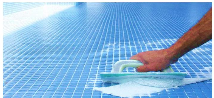
⑥ Para áreas sumergidas o de exigencias de protección antimicrobiana, se recomienda el uso de fragüe epóxico (ej. SPECTRALOCK de Laticrete, PERMACOLOR).
