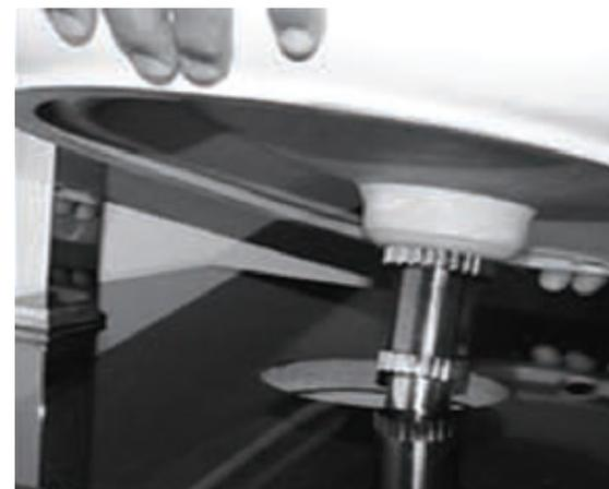
6- Ubique con mucho cuidado el lavamanos sobre el mesón. En primero lugar, inserte el tubo de cola previamente instalado en el drenaje del desagüe. Posteriormente, alinee de forma correcta el lavamanos.
