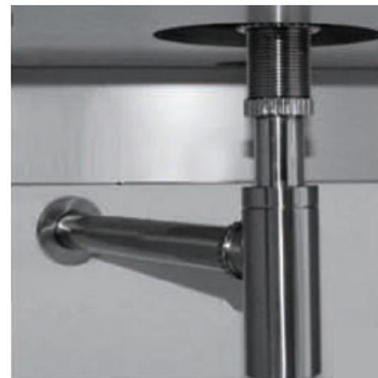
8- Deslice las arandelas plásticas y de goma para preparar la conexión entre la tubería del drenaje y el sifón. Complete la instalación conectando el tubo del drenaje a la pared. Compruebe que todas las partes estén debidamente ajustadas para evitar fugas de agua.
