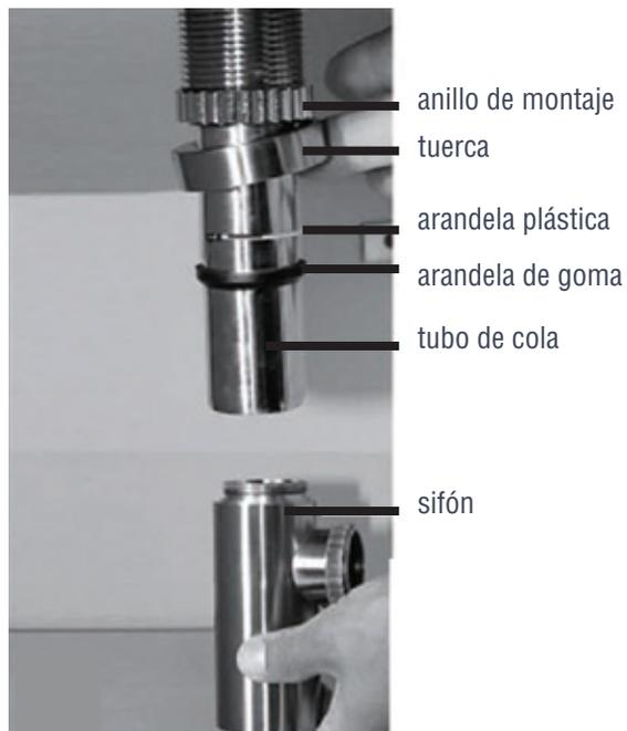
7- Deslice las arandelas plásticas y de goma para preparar la conexión entre el drenaje del desagüe y el sifón. Apriete girando la tuerca para ajustar el sifón con el tubo de cola.
