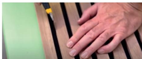
10. Para realizar terminaciones en los extremos, corte un listón de la misma pieza y despegue la capa acústica de fibra Pet. Puede utilizar el listón para las distintas terminaciones.
