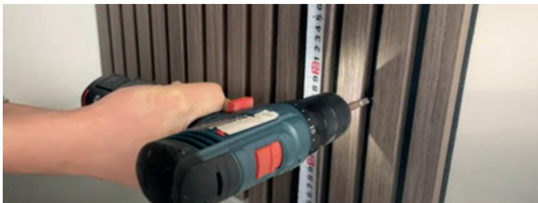
4. Continúe colocando los tornillos hacia arriba, dejando una separación de 60cm sobre la primera fila de tornillos (la que se ubicó previamente a 20 cm del inicio de la pieza).
