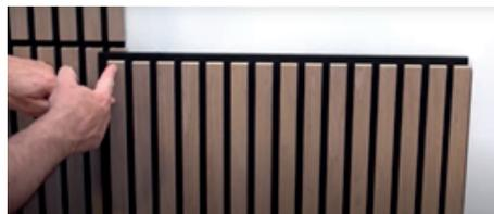
9. Corte por el frente de la pieza la Fibra Pet, dejando pestaña para que quede dentro de la que ya está en el muro.
