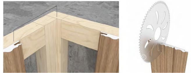
**7.** Instale el panel bien cortado y fíjelo a la viga de madera en un ángulo de 45° con clavos de aire.
