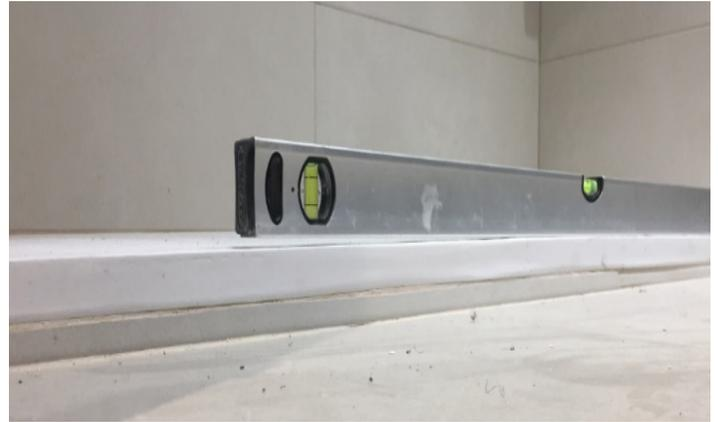
La máxima desviación de planeidad aceptable es de 3 mm por 2 metros lineales. Si las diferencias en el sustrato exceden esta tolerancia, es necesario regularizarlo antes de la colocación, usando mortero de nivelación o autonivelante.
