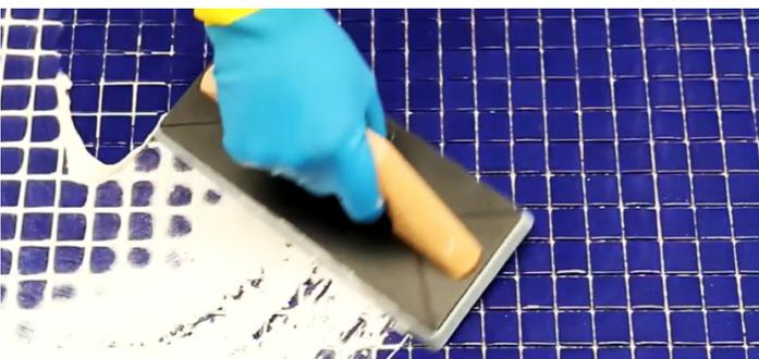
⑤ Una vez transcurrido el tiempo completo de secado recomendado por el fabricante del adhesivo, se puede proceder con el fragüe. El fragüe debe ser aplicado de acuerdo a las indicaciones del fabricante del mismo.
