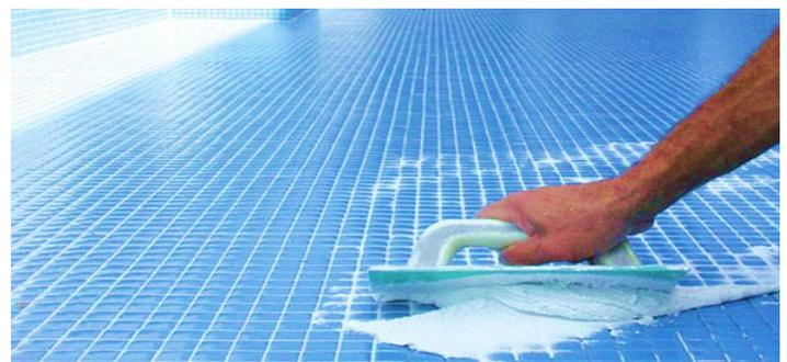
⑥ Para áreas sumergidas o de exigencias de protección antimicrobiana, se recomienda el uso de fragüe epóxico (ej. SPECTRALOCK de Laticrete). Para otras áreas, se puede utilizar fragüe cementicio (ej. PERMACOLOR de Laticrete).
