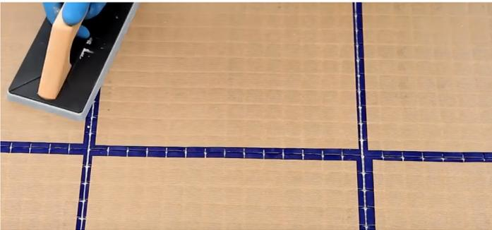
③ Acomode debidamente la palmeta y aplastar con llana lisa de goma. Importante colocar separador de 3 mm entre palmetas, para lograr un alineamiento integral entre palmetas.
