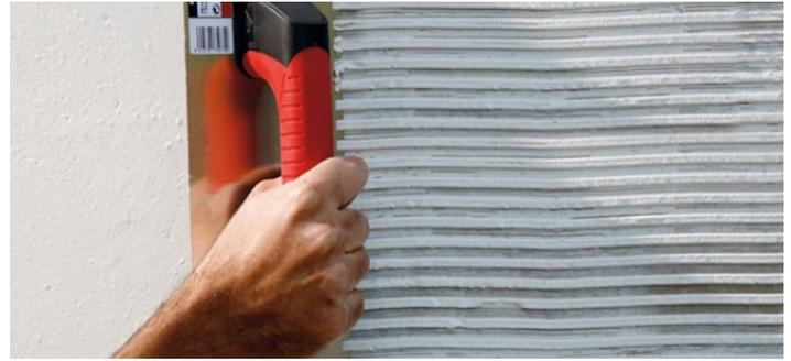
② Aplicar adhesivo en la superficie con llana dentada de tamaño adecuado, la recomendada es de 6x6 mm. Aplique también, con llana lisa, sobre la palmeta (doble encolado); luego coloque el mosaico sobre el adhesivo que se encuentra en la superficie.
