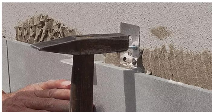
⑥ Considerar que, en una altura superior a 3 metros, algunas normativas internacionales prevén la colocación con un sistema mixto adhesivo-anclaje mecánico, a elegir en relación al peso de la pieza, la altura del revestimiento y las condiciones de obra.
