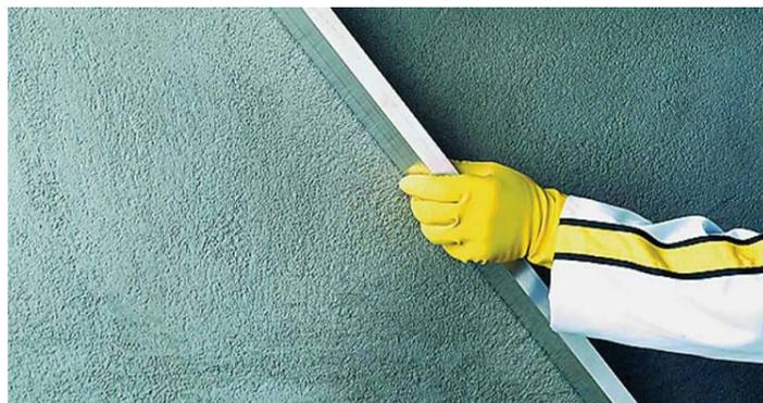
② El sustrato debe estar curado (28 días según NCH 170). También debe estar limpio y nivelado (UNE 138002). La superficie debe ser resistente, estar limpia y libre de polvo, aceite, grasa, pintura, selladores de hormigón, compuestos de curado, etc.
