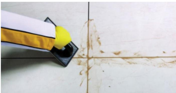
⑨ Aplique el fragüe en forma correcta y limpia, no deje secar este producto sobre la superficie de los revestimientos durante el proceso de instalación. Los restos deben ser limpiados durante la instalación y cuando están en estado crudo (máximo 30 min después de aplicados).
