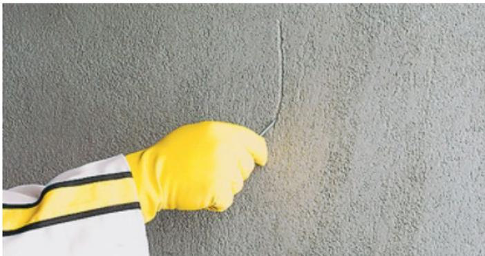
① De acuerdo las características técnicas del hormigón no se recomienda colocar revestimientos cerámicos sobre un radier "verde" (concreto sin curar). Se debe disponer de un soporte estable y sin fisuras.
