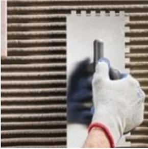
Dependiendo del adhesivo que se coloque **se recomienda instalar de 2 o 3 hileras diario máximo** para no tener problemas de deslizamiento.
