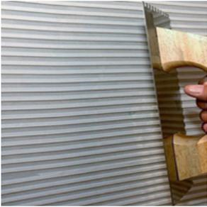
En cuanto a los adhesivos, se recomienda tener en cuenta el tipo de baldosa, la superficie del soporte, las condiciones ambientales y las exigencias del recubrimiento para elegir la opción adecuada. Por ejemplo, en recubrimientos cerámicos sobre soportes inestables de Clase 2, optaremos por adhesivos cementosos deformables (C-1 S1 / C-2 S1) o, en su caso, muy deformables (C-1 S2/C-2 S2) descritos en la norma UNE-EN 12004.
