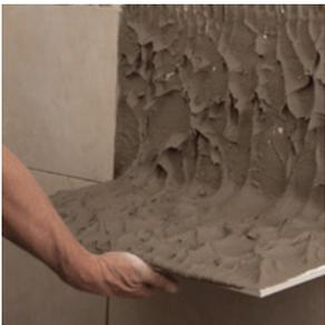
Para una correcta instalación debemos recordar que la **absorción** de los gres porcelánicos corresponden entre 1-3% por tanto siempre se debe realizar doble encolado con adhesivo seleccionado.
