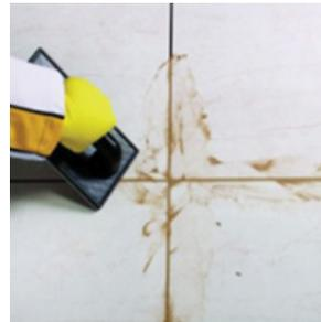
**Aplique el fragüe en forma correcta y limpia**, no deje secar este producto sobre la superficie de los revestimientos durante el proceso de instalación. Los restos deben ser limpiados durante la instalación y cuando están en estado crudo (máximo 30 min después de aplicados).
