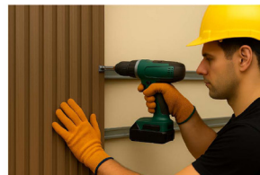
3. MONTAJE: Instalar el resto de los paneles con clips AW08 fijados al perfil metálico.
