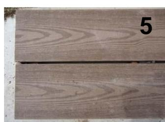
UNIÓN DE PIEZAS DECK WPC UTILIZANDO K2 EN LOS CABEZALES Y FIJACIONES EN EL RESTO DE LA LONGITUD DE LA PIEZA, ATORNILLADO EN LOS APOYOS DE CADA VIGA.
