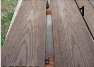
UBICAR LOS ELEMENTOS DE ANCLAJE PARA EL DECK WPC, **K2** Y **FIJACIÓN**, EN EL EXTREMO DE LA PIEZA Y EN CADA APOYO DE LA VIGA RESPECTIVAMENTE
