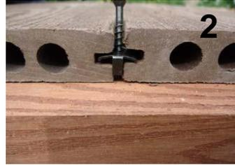
INSTALACIÓN DE ANCLAJE K2 SIEMPRE EN LOS EXTREMOS DE CADA PIEZA, ATORNILLADO EN EL EJE DE LA VIGA
