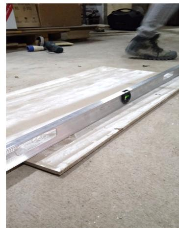
Superficie plana y nivelada, se tiene que usar un nivel de mano para medir la diferencia que se produce entre el mismo y la palmeta. Verificando que sea la tolerancia máx. admisible según el punto anterior.
