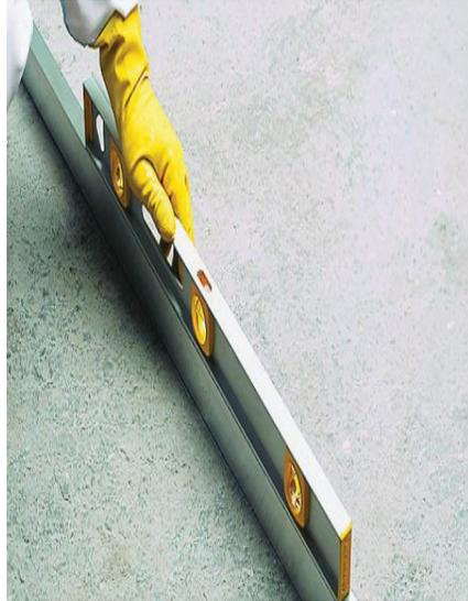
Comprobar que el sustrato no tenga fisuras, que esté correctamente homogéneo, completamente limpio y nivelado. El sustrato debe estar curado (28 días).
